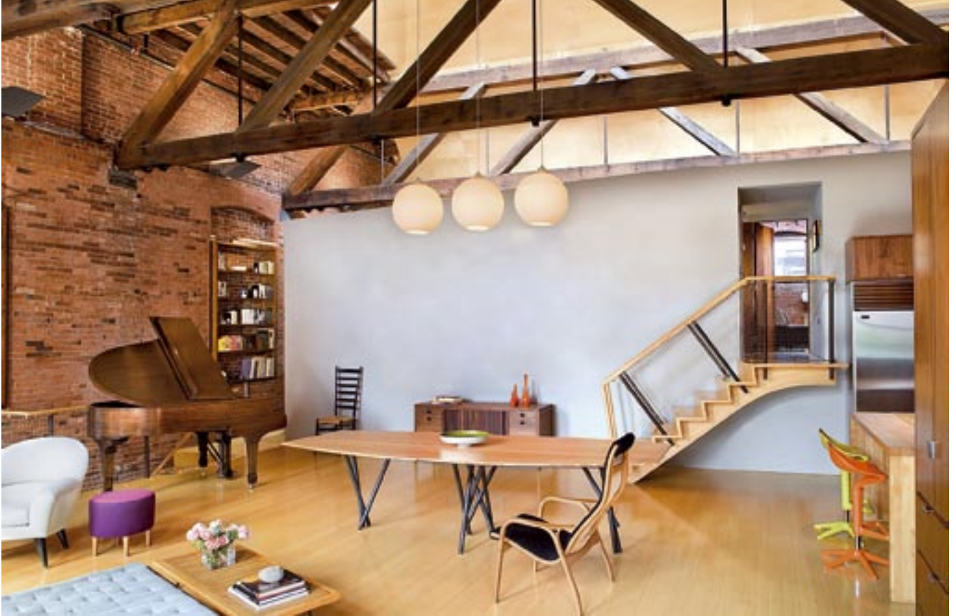
Yläkerroksen asunto sijoitettiin kaksimetristen, puhdistettujen ja kunnostettujen kattoristikoiden alle.
