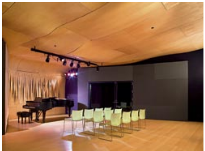
Musiikkisalin aaltoileva vanerikatto muuntuu esiintymistilan takana uritetuksi ääntä hajottavaksi pinnaksi.
