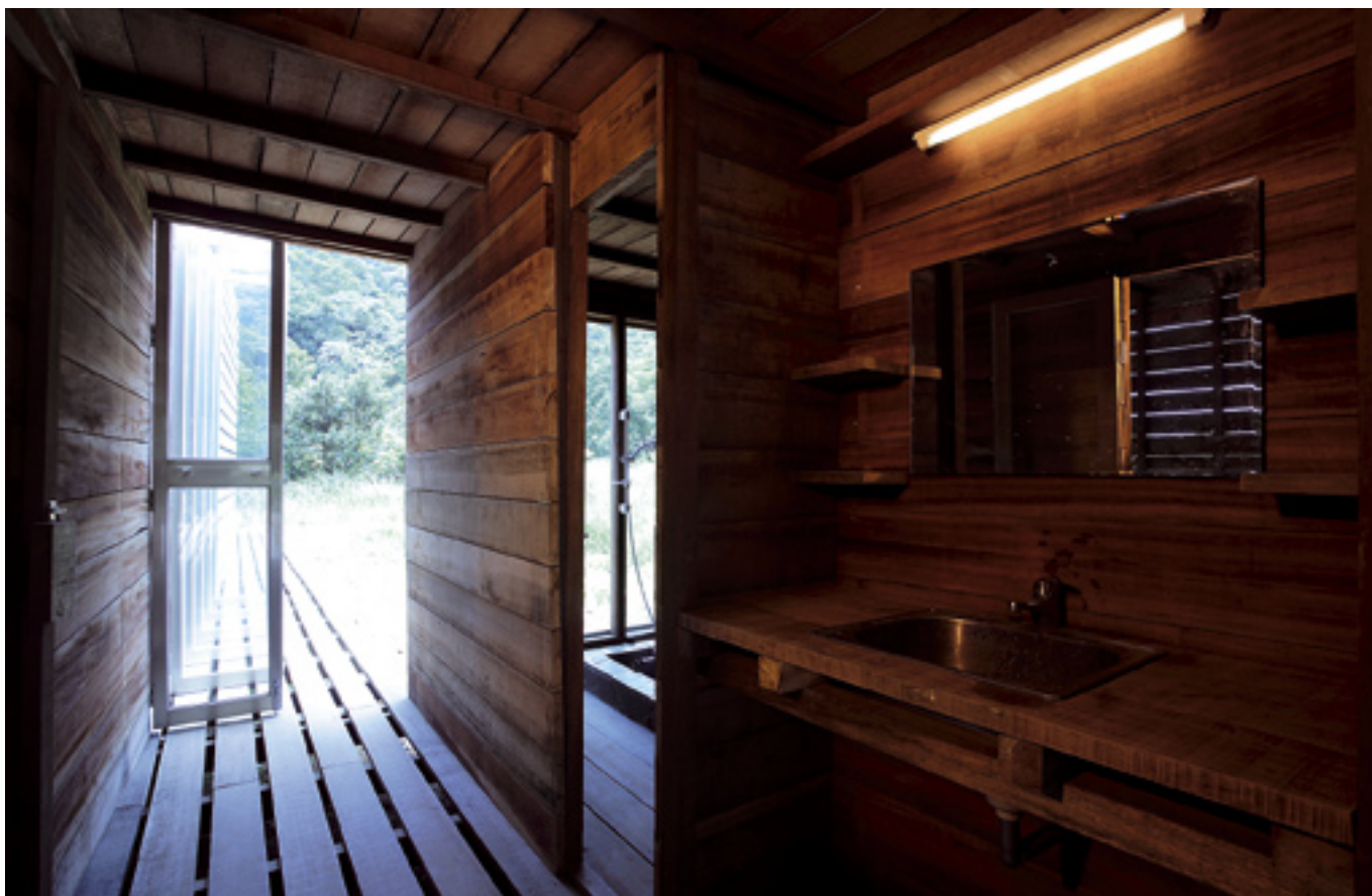
Rakennusmateriaalina on käytetty paikallista, ei-uhanalaista merandi-puuta.
