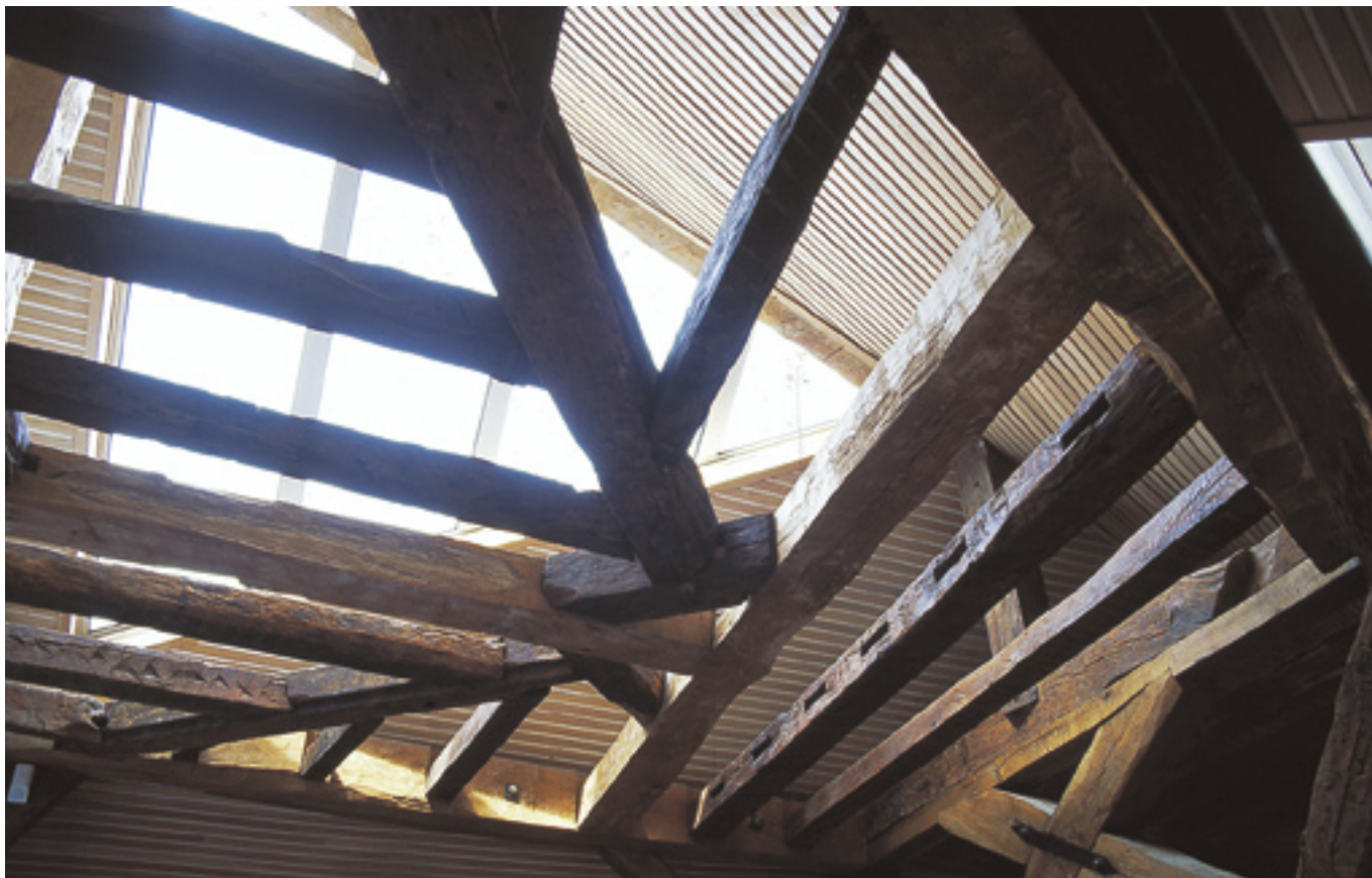
Vanhat, monimutkaiset rakenteet hallitsevat tilaa. Uudet osat tehtiin keveinä ja yksinkertaisina
